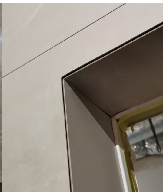
Укладка керамогранита, запил под 45, люки скрытого монтажа
