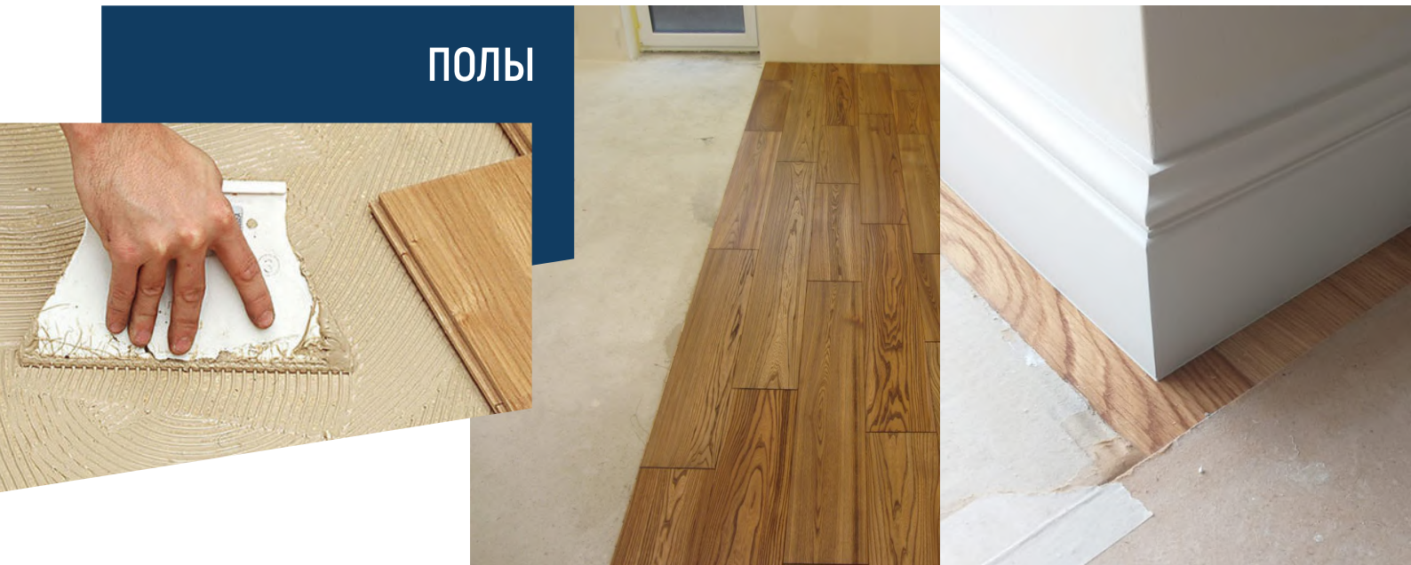
Укладка инженерной доски, монтаж плинтусов под покраску
