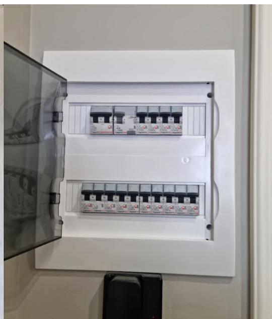
Разводка электрики, сборка коробки автоматов, монтаж трасс для кондиционеров
