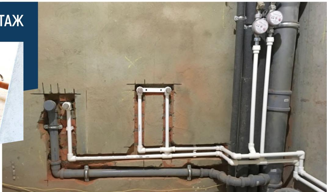
Тройниковая разводка водоснабжения и канализации, материал - полипропилен
