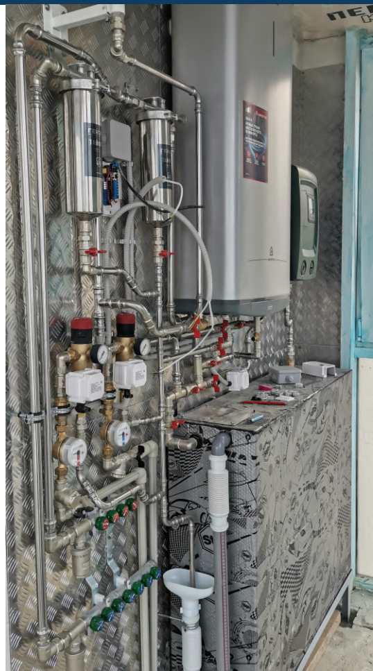
Коллекторная разводка водоснабжения, материал - нержавеющая сталь/медь, системы фильтрации и очистки воды
