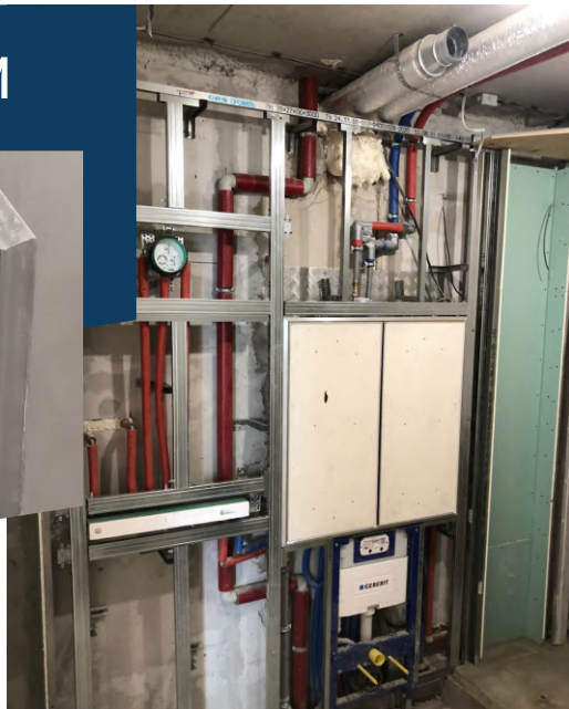
Гидроизоляция мокрых зон, установка скрытых люков под плитку
