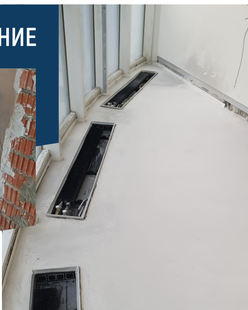
Коллекторная разводка отопления, монтаж внутрипольных конвекторов
