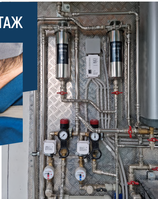
Коллекторная разводка водоснабжения, материал - нержавеющая сталь/медь, системы фильтрации и очистки воды
