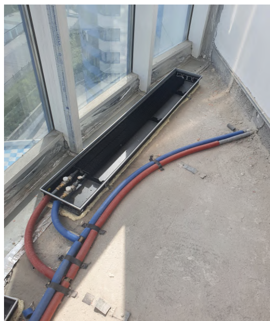
Коллекторная разводка отопления, монтаж внутрипольных конвекторов
