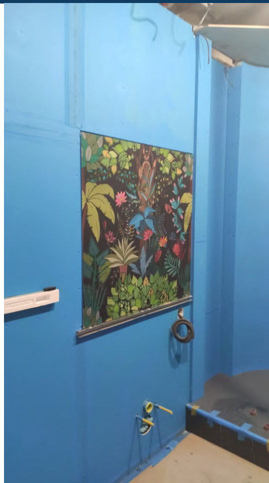
Гидроизоляция мокрых зон, установка скрытых люков под плитку
